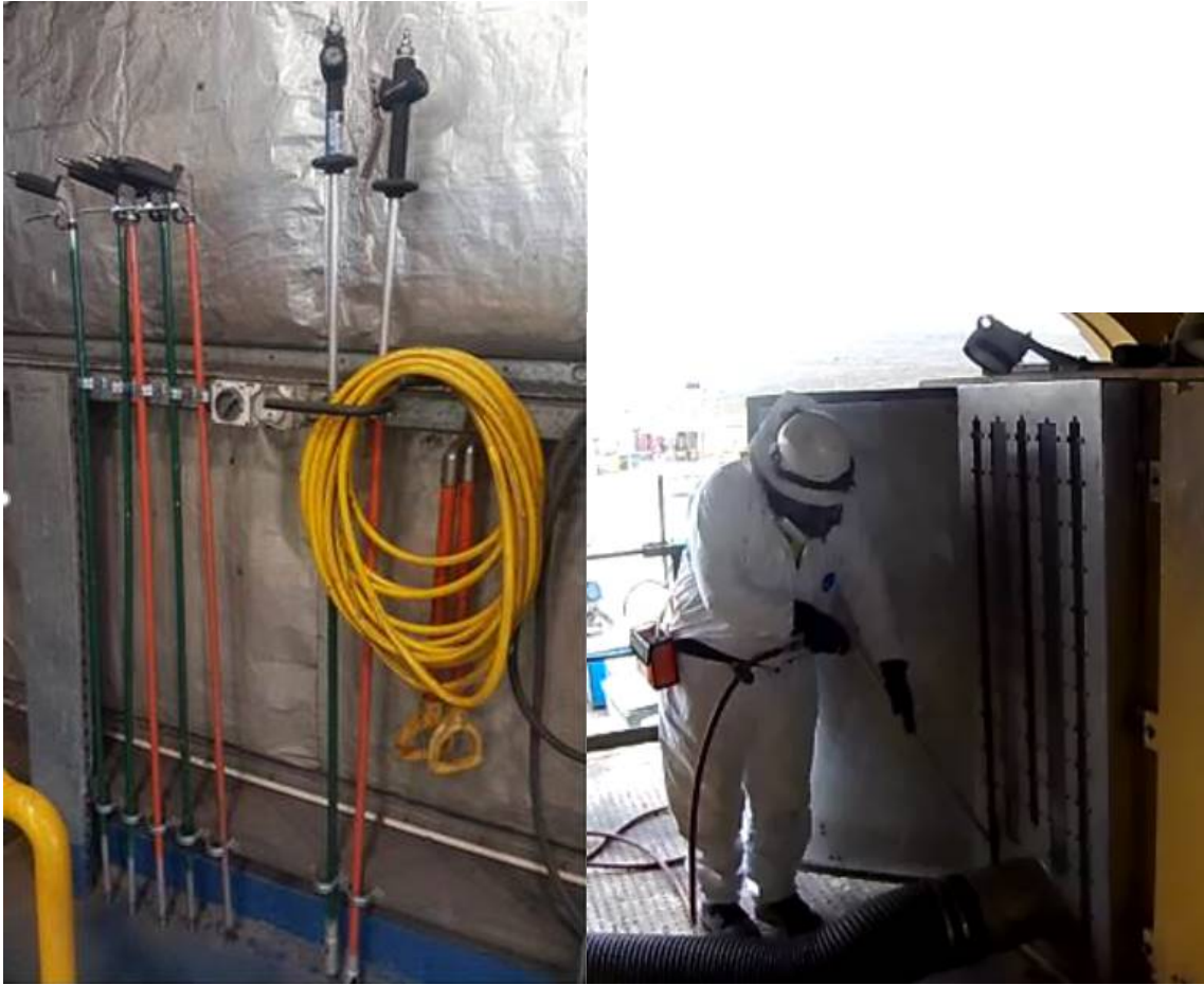
Figures18 & 19. The utilisation of extended air lances
